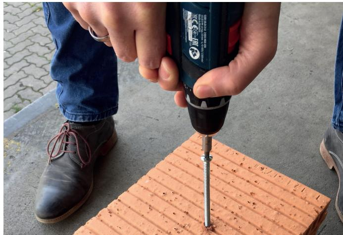
Durch die Vorbohrung entsteht ein ausreichender Schraubwiderstand beim Einschrauben im Hochlochziegel. Somit ist ein ausreichender Quer- und Auszugswert zu erreichen.
